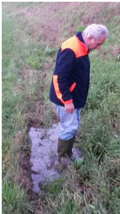
Figura 2-6: Venuta d'acqua al piede del rilevato arginale a lato campagna.
